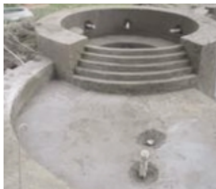
Fasi di lavorazione: scavo, massetto di fondo, platea armata, pareti, sistemazione finale
