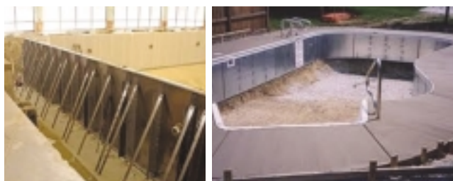
Fasi di lavorazione: scavo, massetto di fondo, pareti con pannelli prefabbricati, rivestimento in liner sistemazione finale
